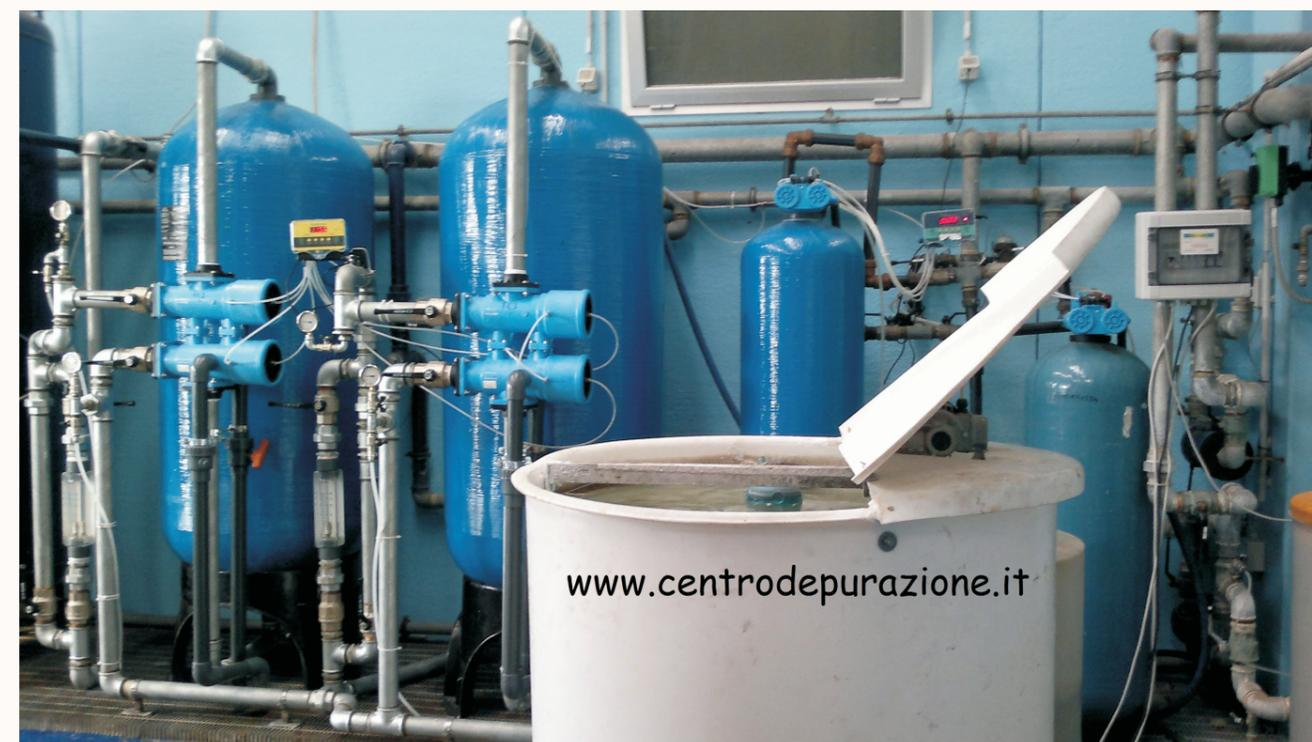
**Impianti completi per filtrazione acqua a carbone attivo e quarzite**
